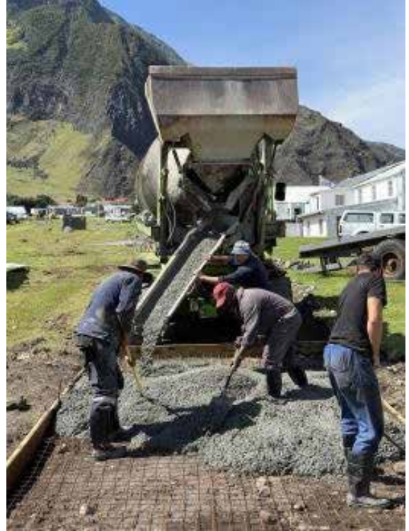
Pouring new concrete.
